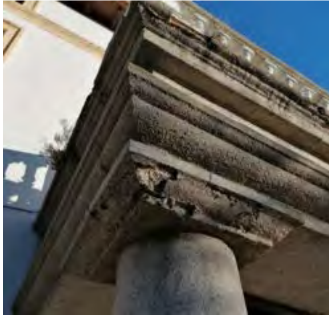
Detalle del capitel y columna que sostiene la terraza abalaustrada del portón principal de acceso donde se aprecia la escasa calidad del material constructivo (cemento)
