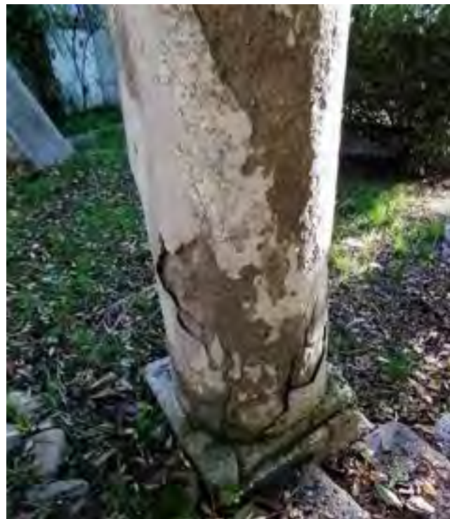
Detalle de la columna de los jardines donde se aprecia la escasa calidad del material constructivo (cemento)
