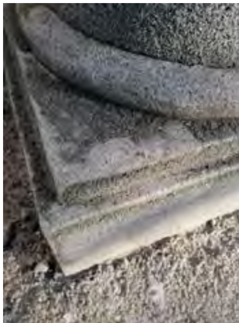
Detalle de la basa y columna que sostiene la terraza abalaustrada del portón principal de acceso donde se aprecia la escasa calidad del material constructivo (cemento).
